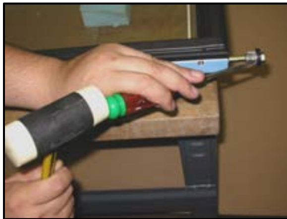
Remove Torque Rod
