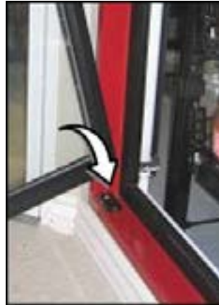
Insert Torque Rod
