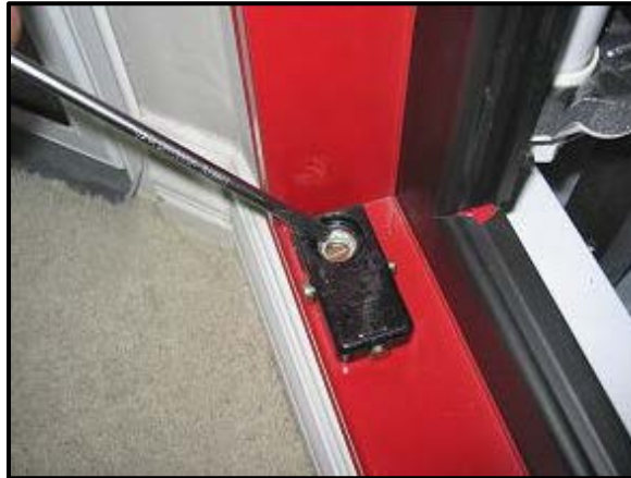
Remove Torquemaster
