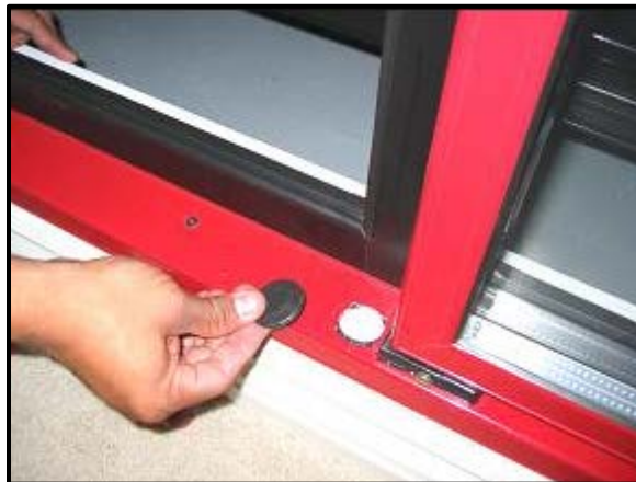
Remove Plug Cap
