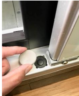
Remove Plug Cap
