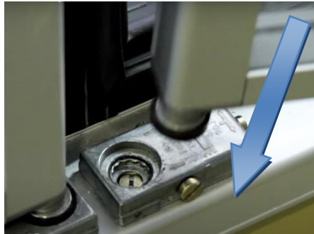
Insert Torque Rod
