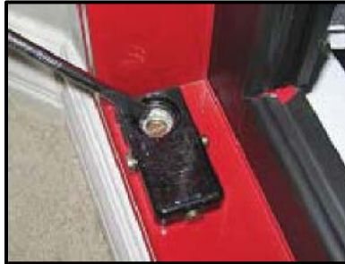
Remove TorqueMaster
