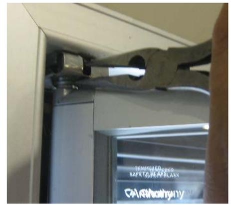
**Figure 12 Disengage Hinge Pin**
